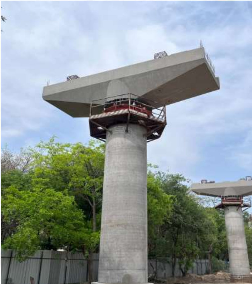
Actual Site Image (Viaduct)
