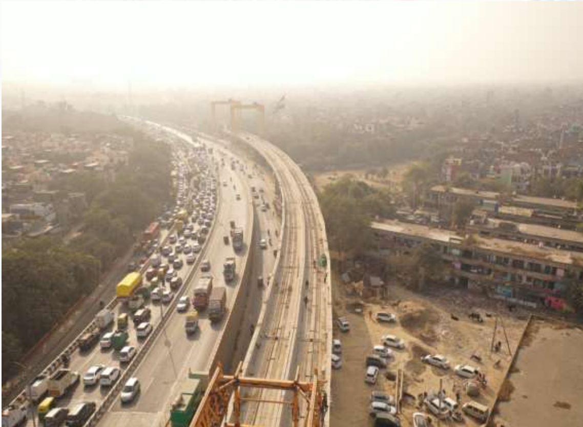
Actual Site Image (Viaduct)
