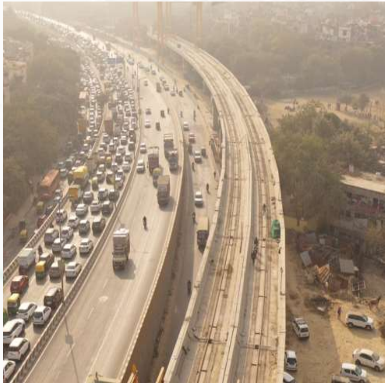
Actual Site Image (Viaduct)
