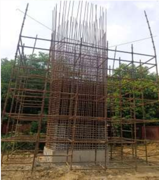
Actual Site Image (Portal Pier)
